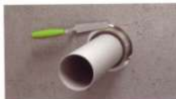
5. Заполните зазор пеной или строительным раствором
